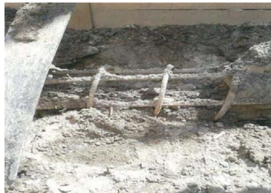
写真 3 支柱の下部の状況
